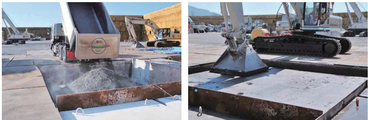
4. 仕切りの一方に盛土材B種を厚さ0.2 mに入れ、錘で圧縮し、厚さ0.25 mの碎石で覆い、打設と圧縮と被覆を繰り返して重層する。
